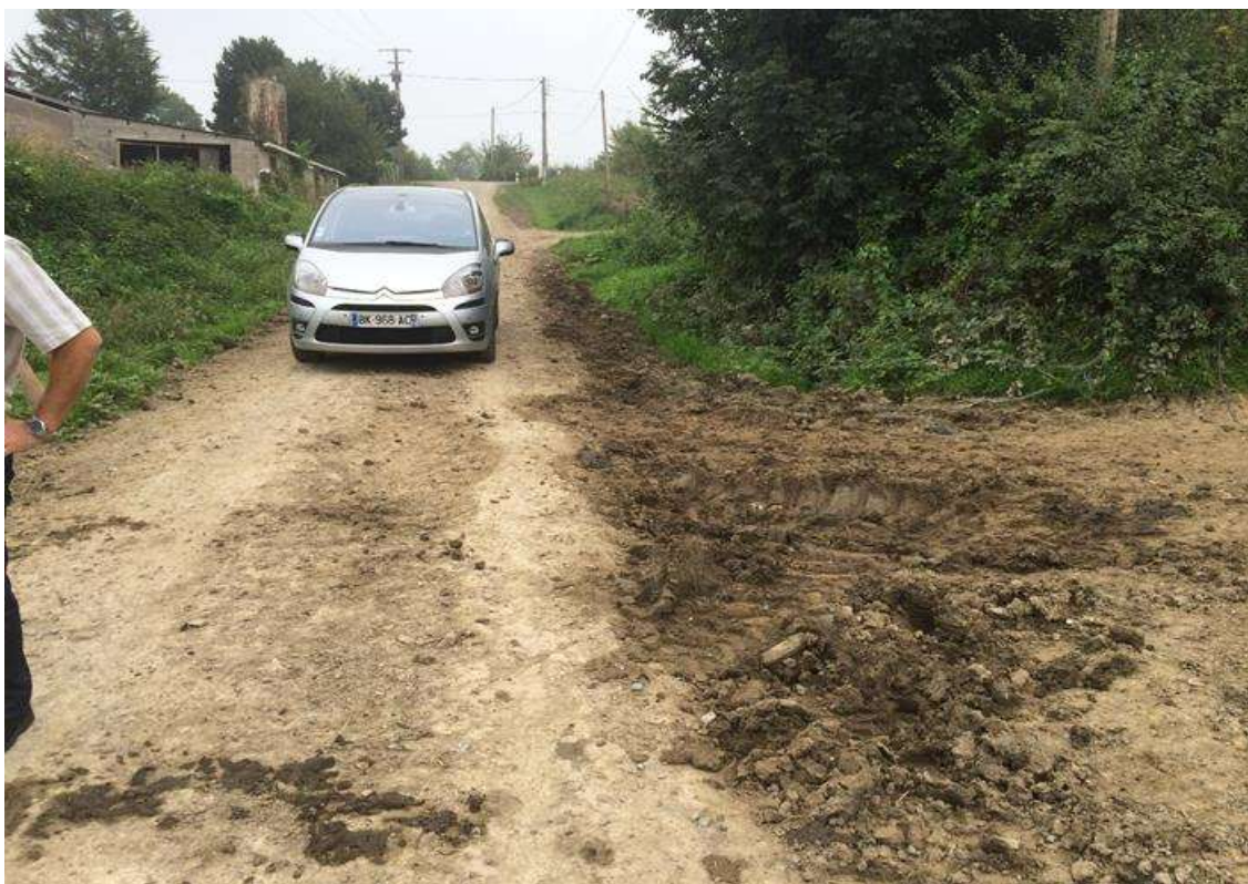
Voie Communale N° 204 appelée prolongement du chemin des Beutiers – AVANT
